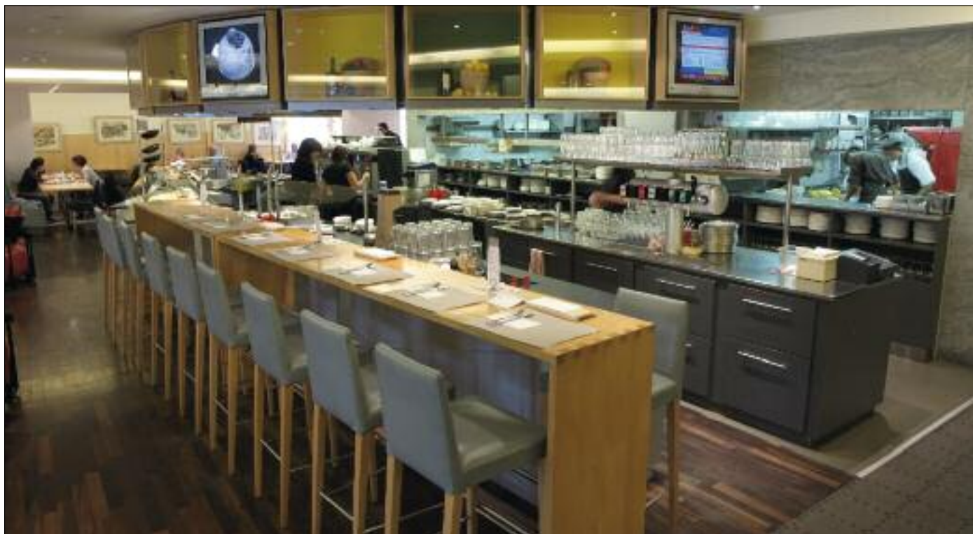
Küche ein neuer MKN-Kombidämpfer HansDampf gold Maxi installiert wurde.
